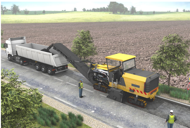
Illustration d'une raboteuse de chaussées en action, en train de produire des agrégats d'enrobés
