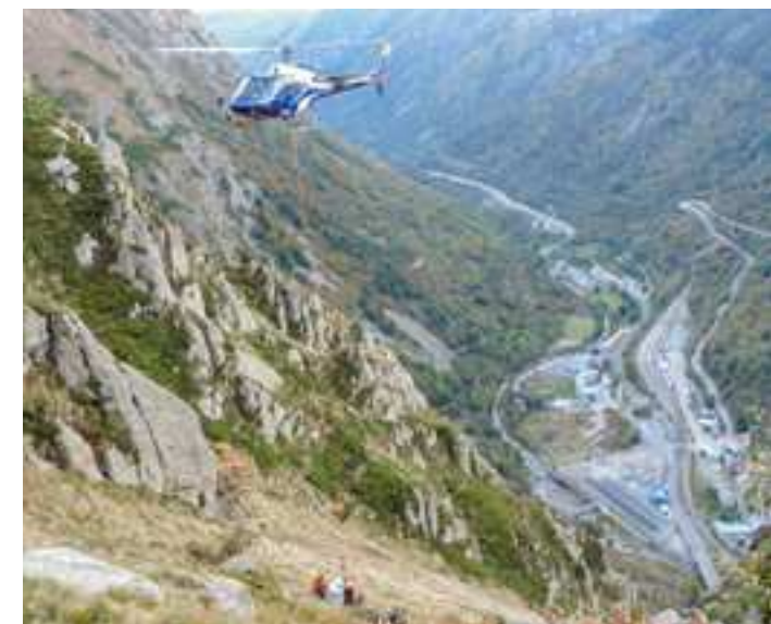
▲ Transport de matériels pour paravalanche par hélicoptère
